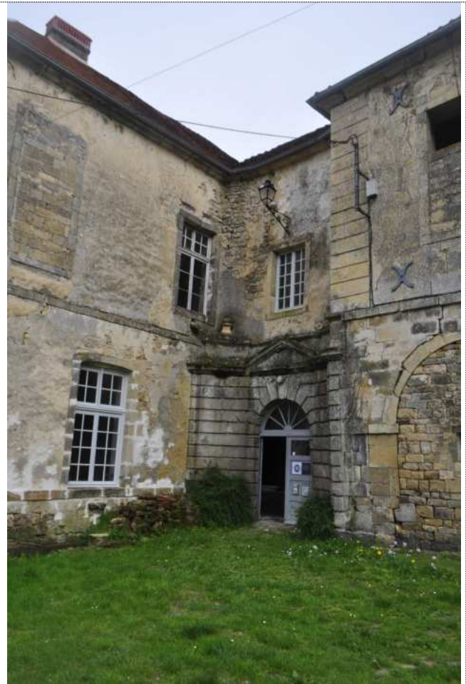
- 745 Entrée monumentale mais dérobée
