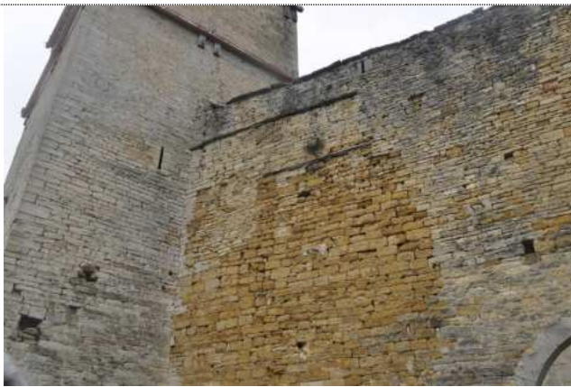
- 910 Créneaux bouchés pour surélever le mur
