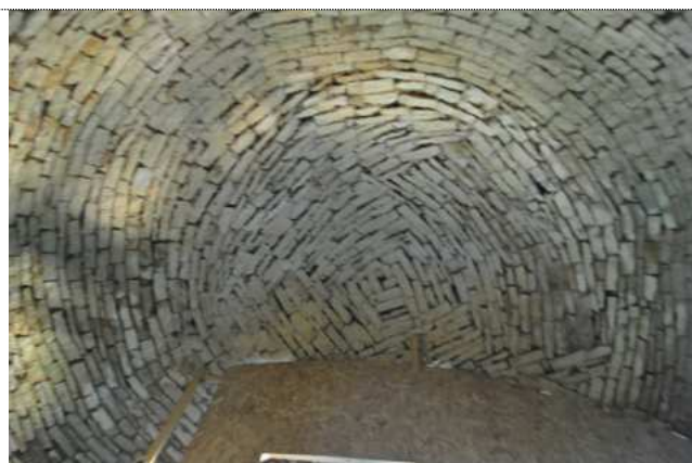
- 585 Intérieur du dôme
