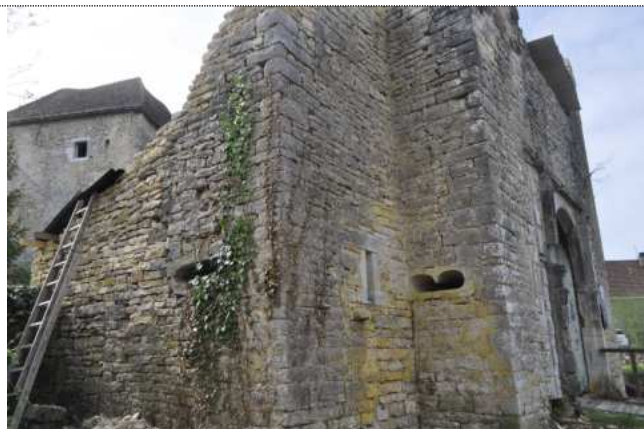
- 829 Tour d'entrée avec modification des ouvertures de tir.
