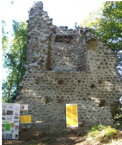
Etats après travaux
