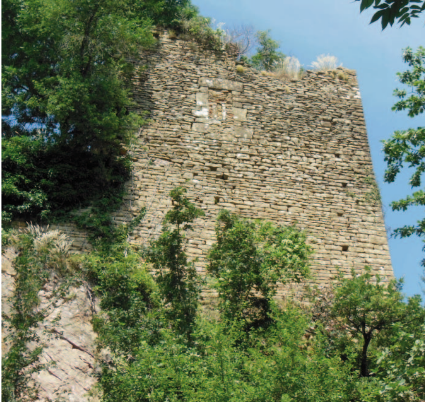
Fig. 34 : façade ouest du mur ouest : baie bouchée.
