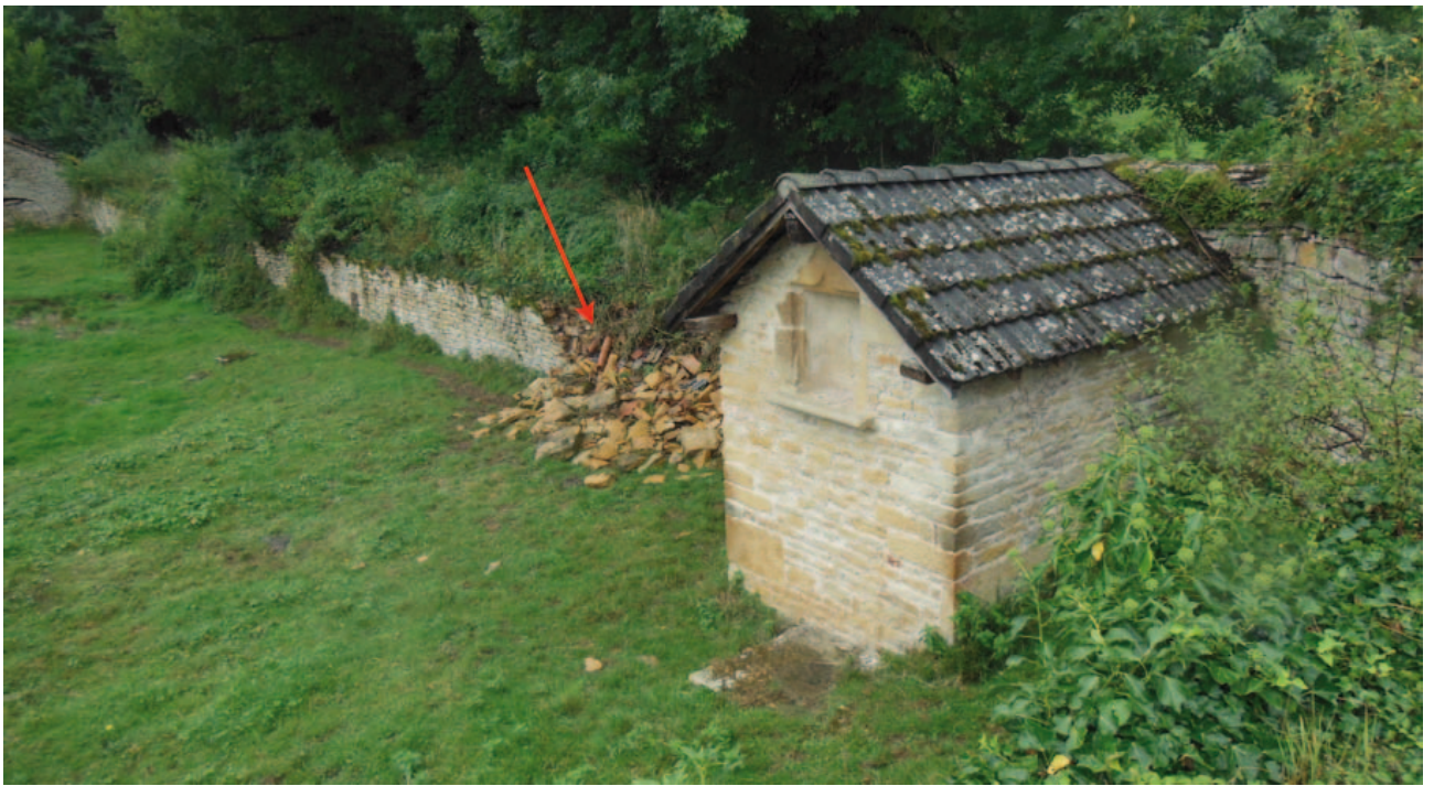
Fig. 3 : la digue de l'étang, vue du nord, et le pavillon nord.
