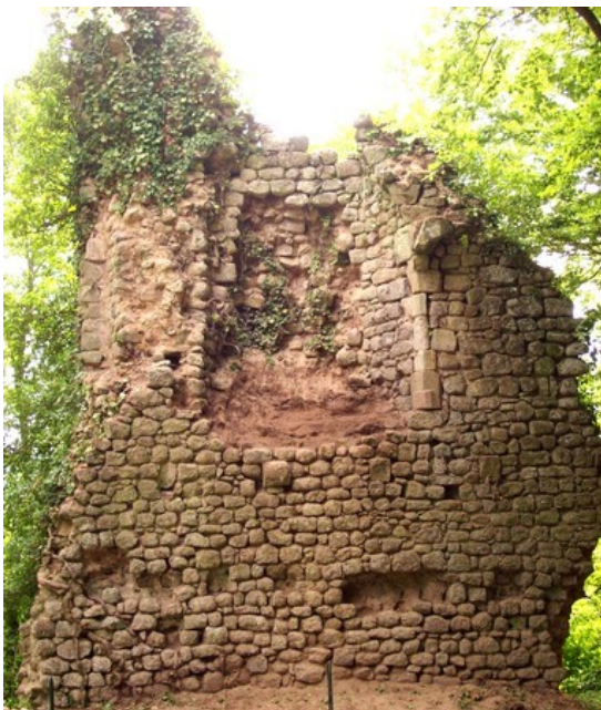
État avant travaux
