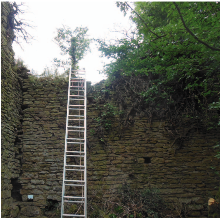
Fig. 35 : façade est du mur ouest : la baie bouchée n'apparaît pas.
