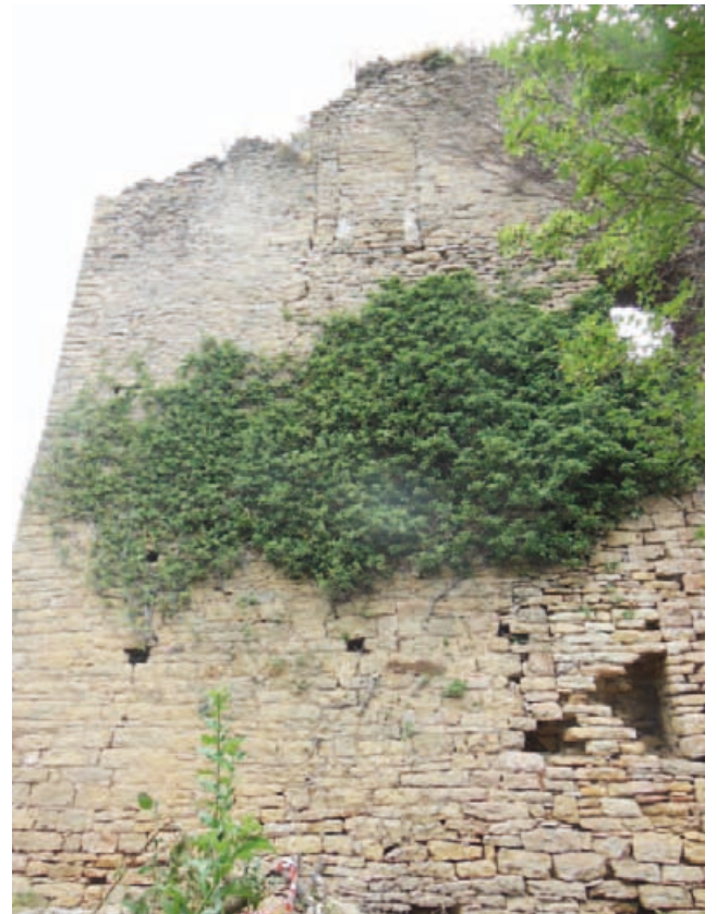
Fig. 27 : angle sud : la latrine, la baie et la poterne.
