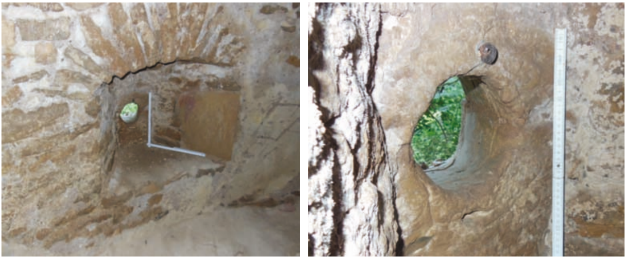
Fig. 17 et 18 : embrasure interne des canonnères du second niveau de soubassement.
