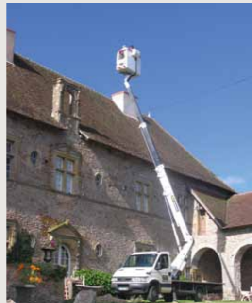
↑ Nacelle élévatrice pour l'étude des parties hautes du château de Montperroux (Saône-et-Loire). Cliché CeCaB.
