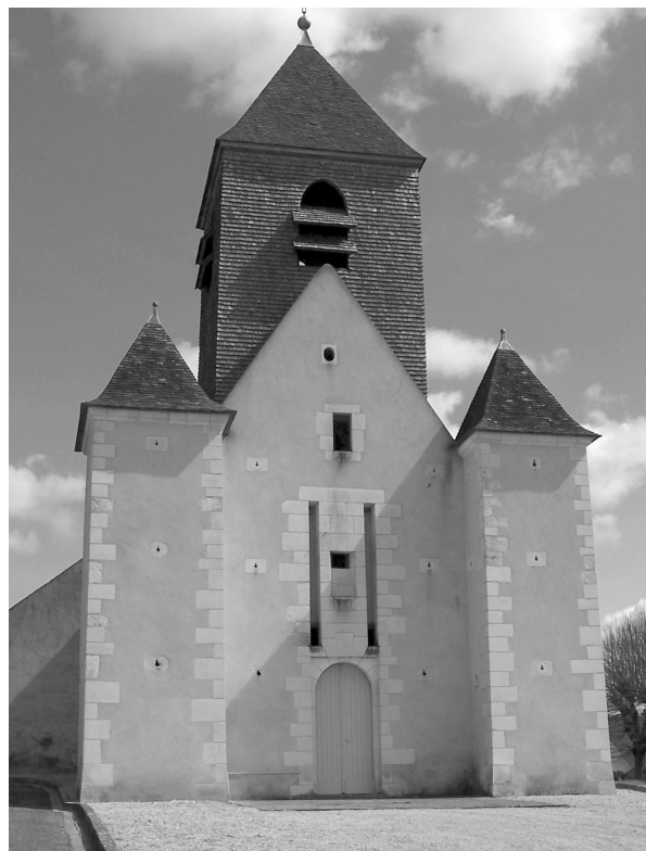
Fig. 48 : vue de l'église Saint-Pancrace de Migennes (89) après restauration.
