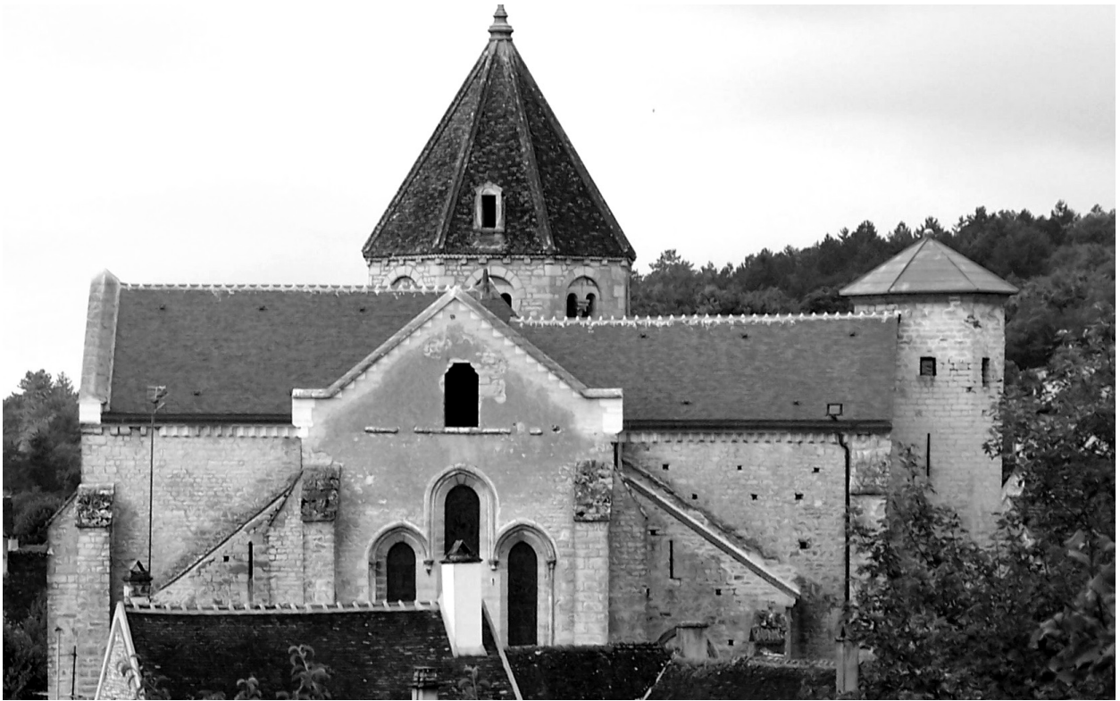
Fig. 43 : vue des vestiges de fortification de l'église de Sacy (89).
