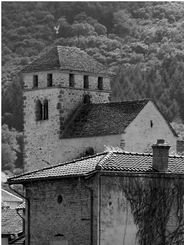
Fig. 28 : vue du clocher de l'église de Sologny (71).
