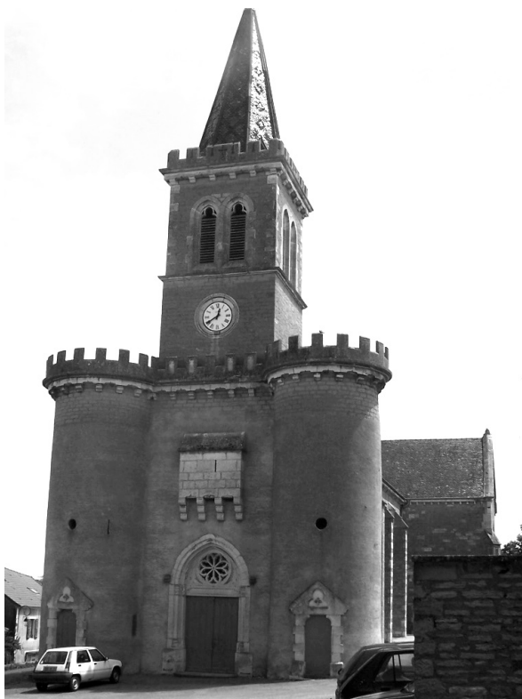
Fig. 46 : vue de l'église de Saint-Désert (71) après restauration.
