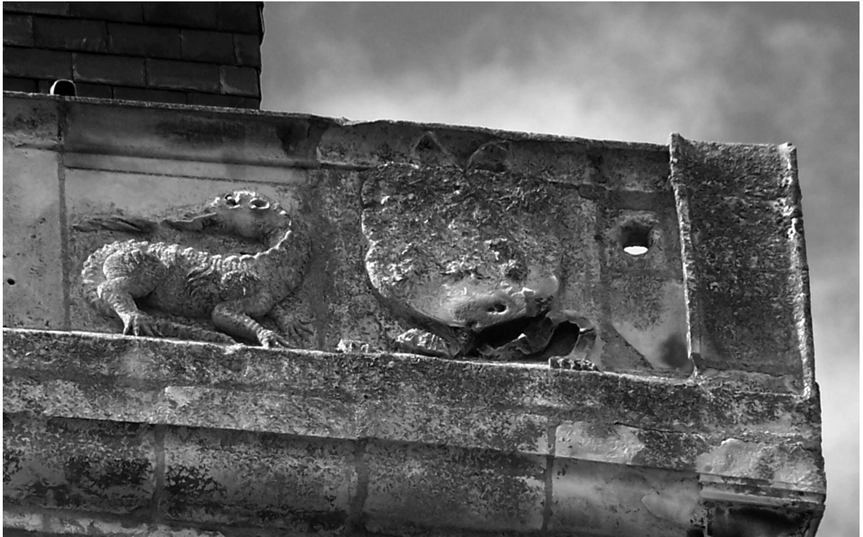
Fig. 32 a : détail des salamandres et des canonniers sur le parapet de l'église de Chevannes (89).
