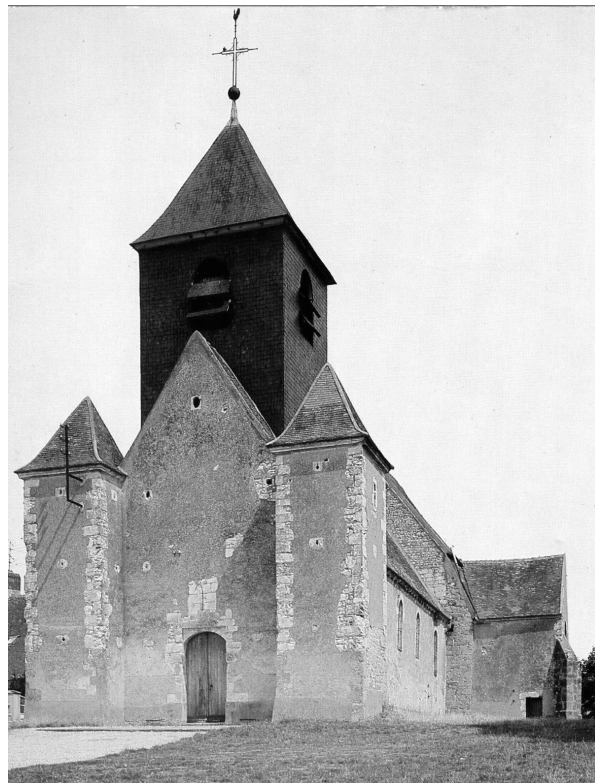
Fig. 47 : vue de l'église Saint-Pancrace de Migennes (89) avant restauration.
