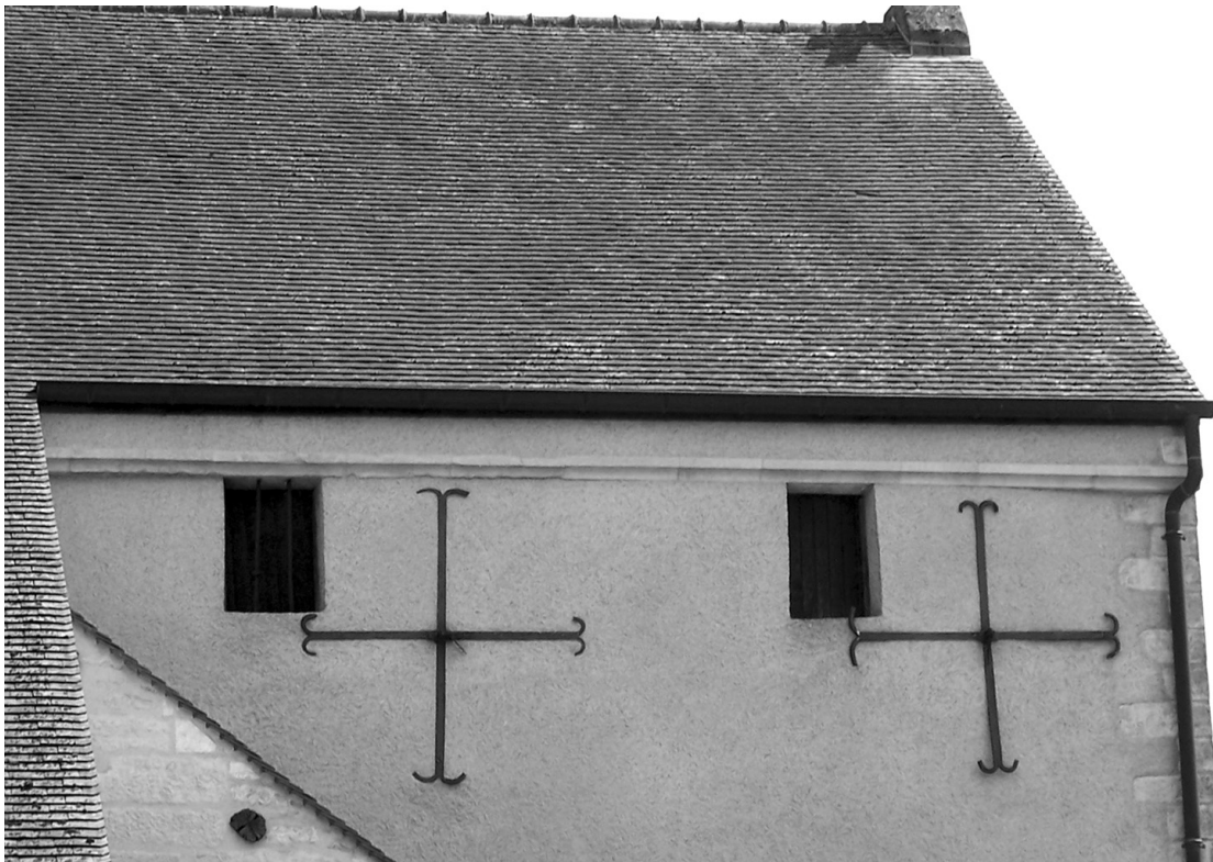
Fig. 40 : vue de détail du comble défensif de l'église de Gemeaux (21).
