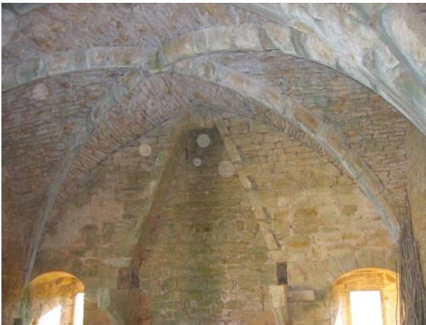
Fig. 5. Voûtes sur croisées d'ogives du rez-de-chaussée surélevé
