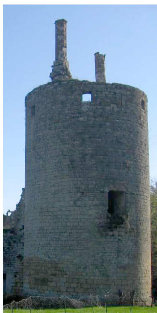
Fig. 11. Tour sud-ouest, face ouest
