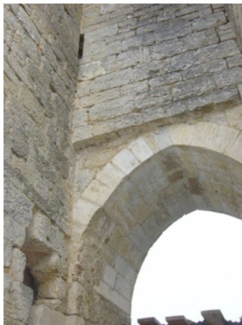
Fig. 3. Logement du tablier
