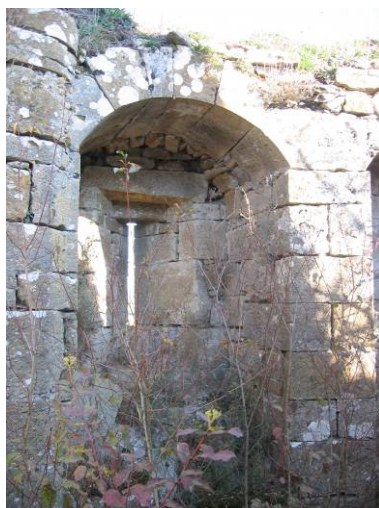
Fig. 18. Étage de tir ; archère sous niche.
