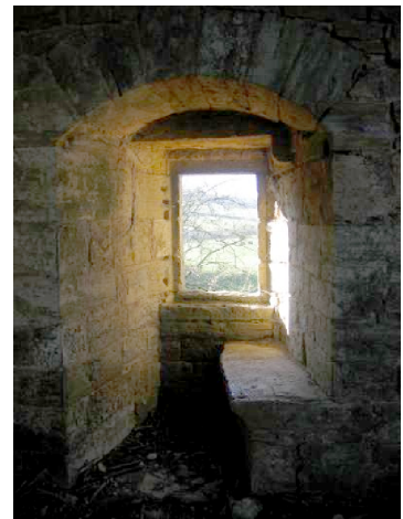
Fig. 6. Fenêtre sous niche et à coussièges de la façade sud
