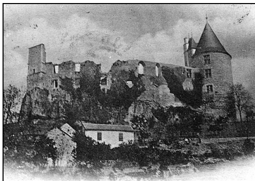
Fig. 8. Vue de la façade est, en 1900
