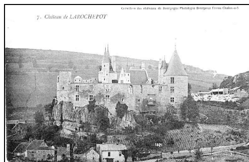
Fig. 12. Vue de la façade orientale en cours de reconstruction (1913)
