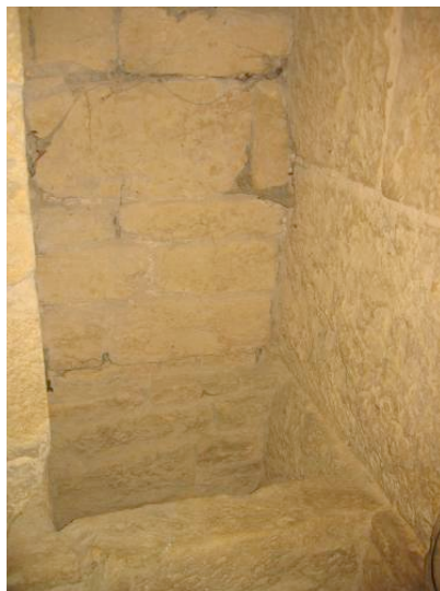
Fig. 10. Tour sud-est, latrines
