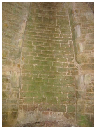
Fig. 14. Cheminée du premier niveau
