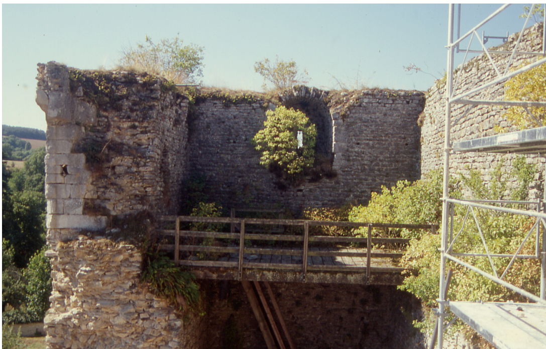
Fig. 3. Vue de l'intérieur de la partie sud-ouest du donjon, avec la porte d'accès (côté sud) et l'archère à niche ouest. Cette archère est la seule archéologiquement complète avec la voûte, les claveaux du départ de l'arc en parement et l'ouverture de tir extérieure. On distingue le niveau du décrochement correspondant au plancher du premier étage, situé nettement plus bas que la base de la porte. (Cl. E. Laborier, Afan, 1999).
