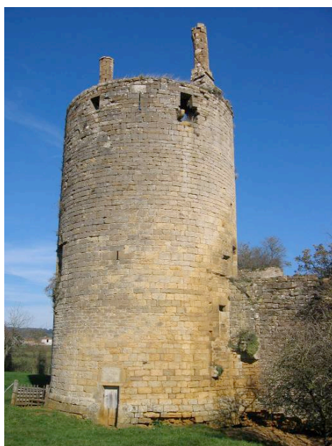
Fig. 12. Tour sud-ouest, face sud
