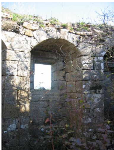
Fig. 17. Étage de tir ; baie-créneau sous niche
