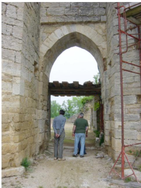
Fig. 2. Vue générale de la porte
