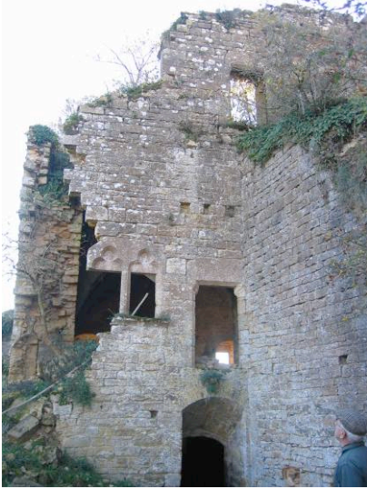
Fig. 3. Tour sud-est, façade ouest sur cour
