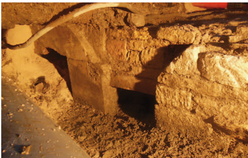
La niche (avec soupirail à gauche)
