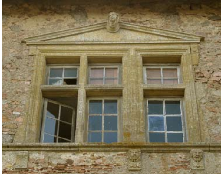
Fig. 33 : croisée à deux meneaux de la grande salle haute, cl. C.C.
