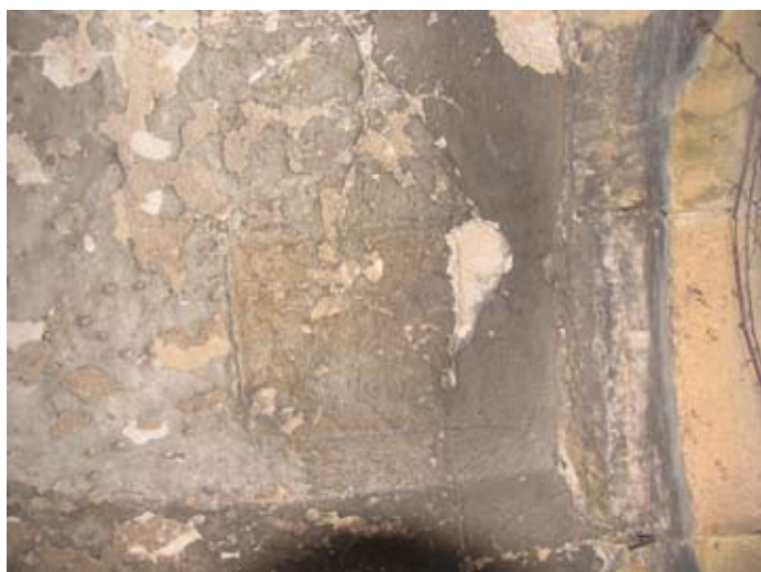
Fig. 7 : faux-joints de l'intrados de l'arcade du bâtiment nord, cl. H. Mouillebouche.
