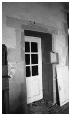
Fig. 14 : faux joints encadrant la porte donnant sur l'aile ouest, 1 er étage, cl. C.C.
