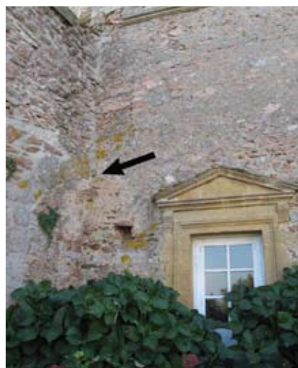
Fig. 8 : mur de clôture ouest : détails des reprises de maçonnerie, cl. C.C.
