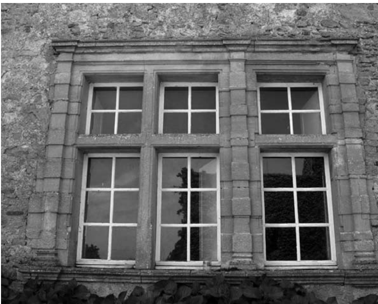
Fig. 32 : croisée à deux meneaux de la grande salle basse, cl. C.C.
