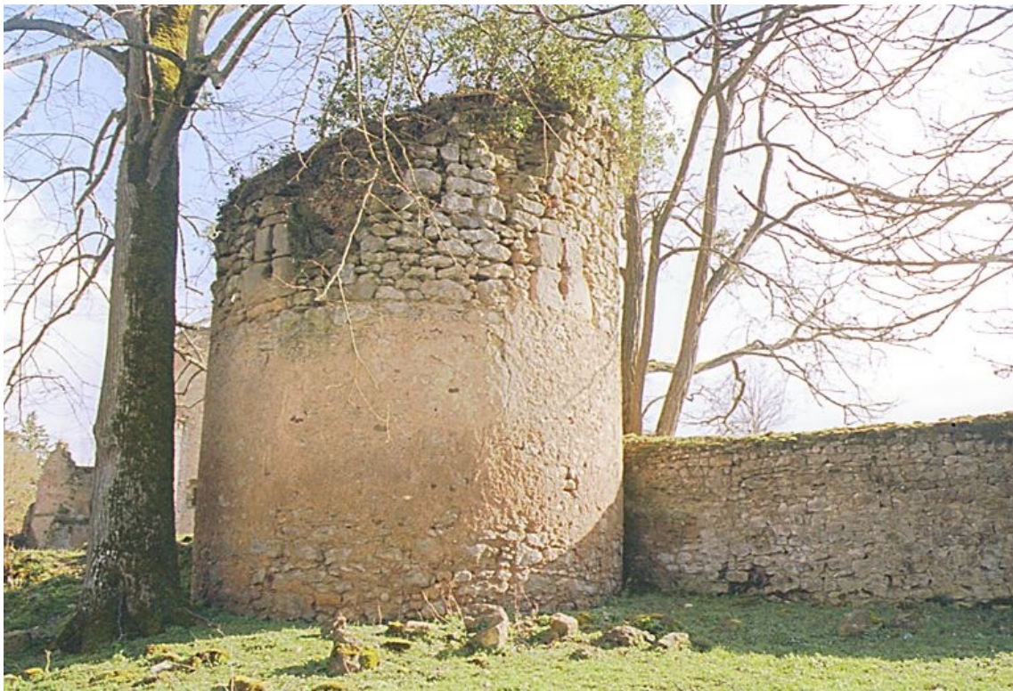
Fig. 5 - La tour dite « du jardin » avec ses archères canonniers et sa fente de visée à croisillon
