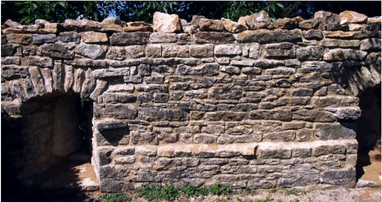
Clichés 7 et 8 – Portion de courtine intégralement jointoyée, côté intérieur.
