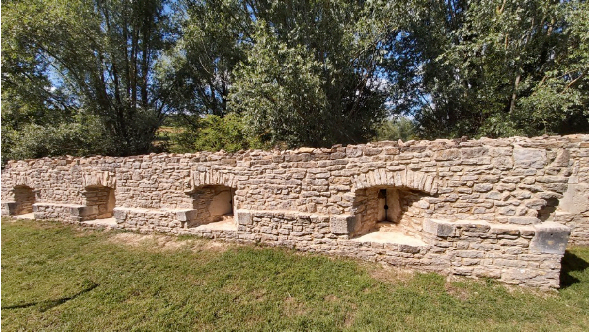
Cliché 13 – Autre vue de l'intérieur de la courtine à cordon d'escarpe après consolidations.
