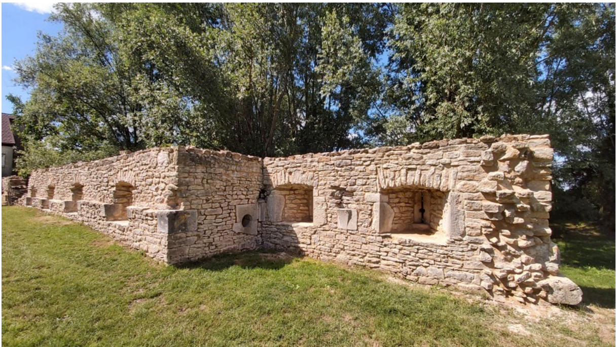
Cliché 12 – Etat de la courtine à cordon d'escarpe une fois les consolidations achevées.
