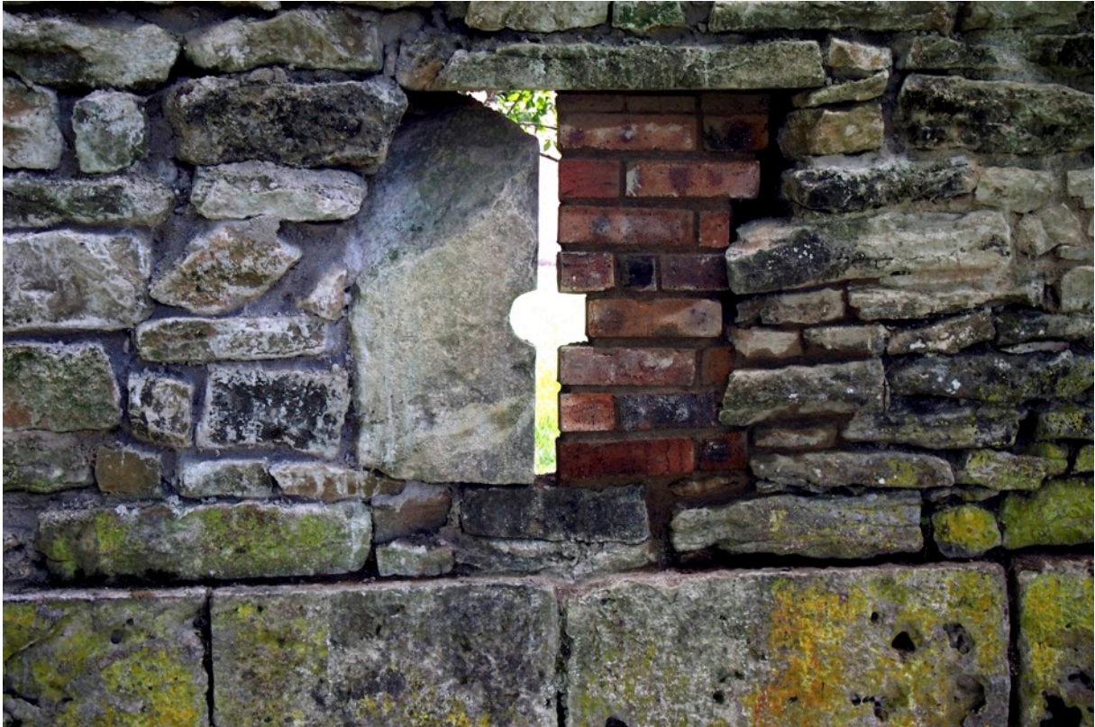
Cliché 11– Vue extérieure du jambage manquant, remonté en briques (archère-canonnaire 15).
