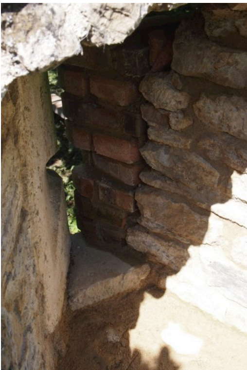
Cliché 9 – Vue extérieure du jambage manquant en cours de remontage (archère-canonnière 14).
