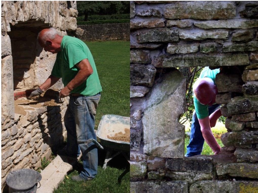
Clichés 4 et 5 – Réfections de la base des niches des archères-canonnières.
