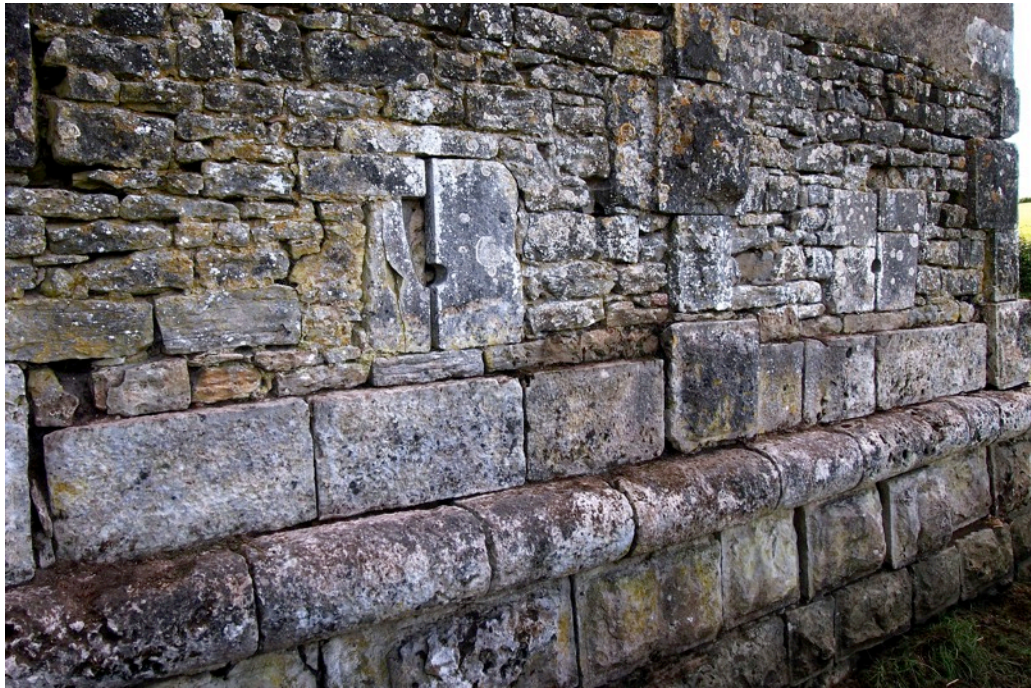
Cliché 3 – Vue de la courtine à cordon d'escarpe, une fois complètement dévégétalisée.
