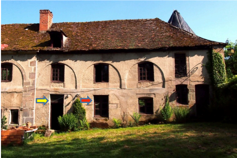
Fig. 11 – Accès à la pièce n°1 (flèche jaune) et fenêtre rectangulaire (flèche rouge).
