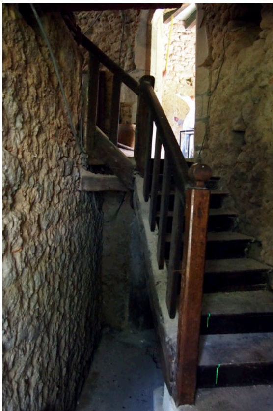
Fig. 9 et 10 – Escalier à quart tournant (à gauche) – Appareillage de l'un des murs (à droite).
