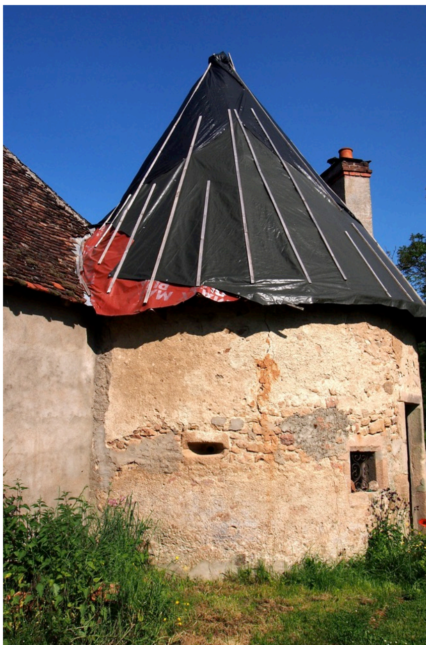
Fig. 13 – Le niveau 1 de la tour ronde des Communs et l'une de ses canonnières.
