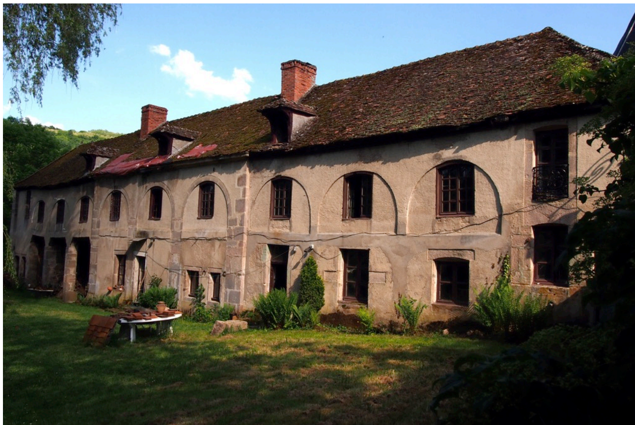
Fig. 7 – Vue de la façade nord des Communs.
